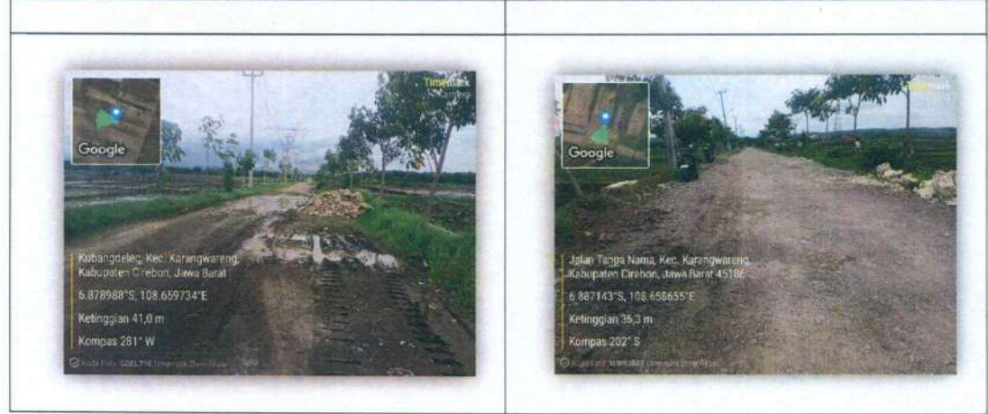
Foto III.21 Perbaikan Jalan menuju TPAS Kubangdeleg
