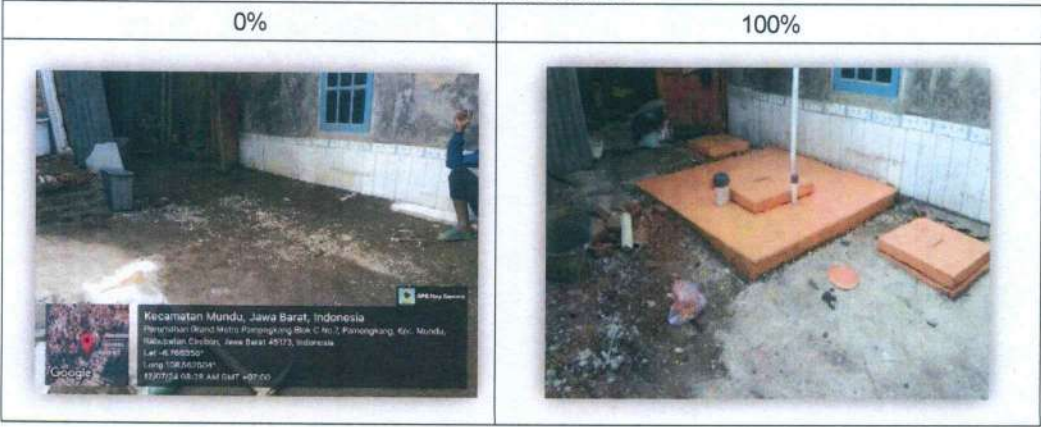
Foto III.22 Pembangunan Tangki Septik Skala Individual Desa Pamengkang Kecamatan Mundu
