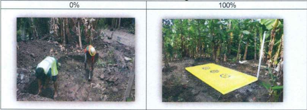
Foto III.23 Pembangunan Tangki Septik Skala Individual Desa Damarguna Kecamatan Ciledug
