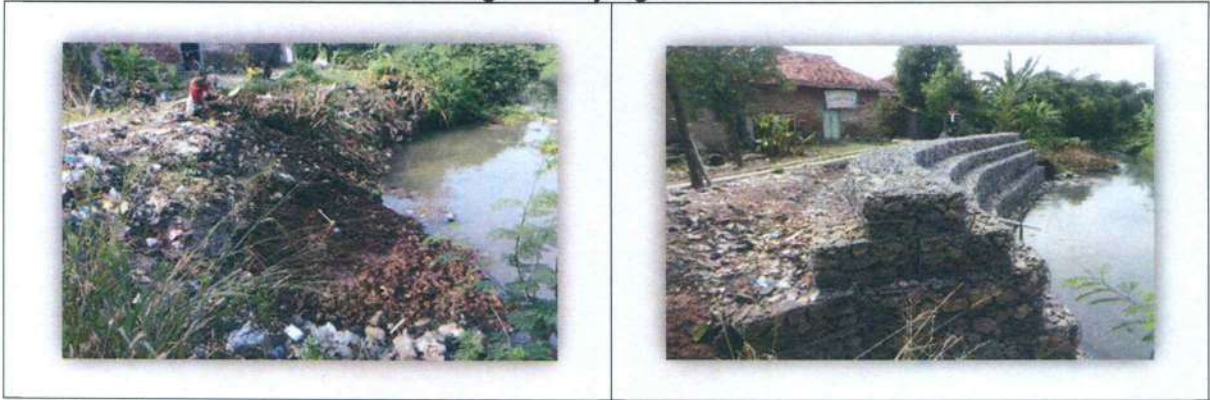
3. Foto III.7 Pemasangan Bronjong Kali Tersana Kec. Pabedilan
