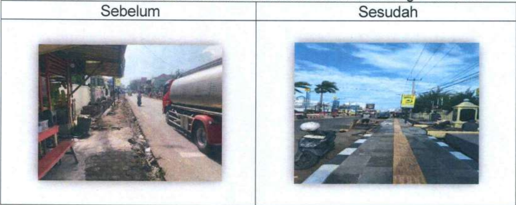
Foto III.2 Pembuatan Trotoar Pada Ruas Jalan Jatiseeng-Pabuaran
