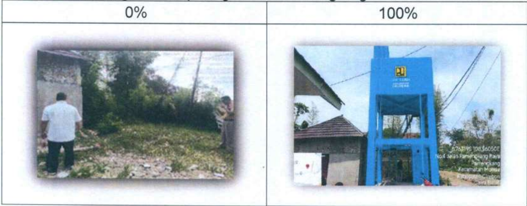
Foto III.19 Uprating Instalasi Pengolahan Air (IPA) / Penambahan Sumur Dalam Terlindungi / Broncaptering di Desa Pamengkang Kecamatan Mundu
