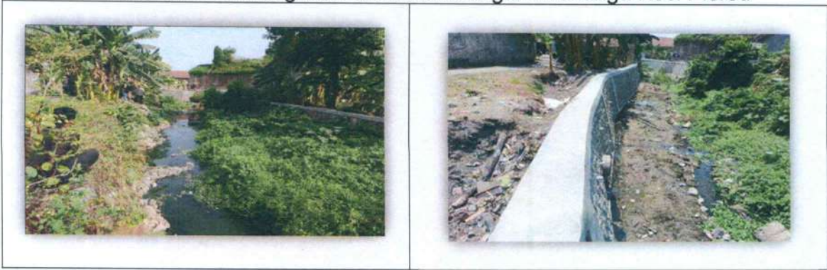
Foto III.6 Pembangunan Senderan Sungai Sikenanga Kec. Plered
