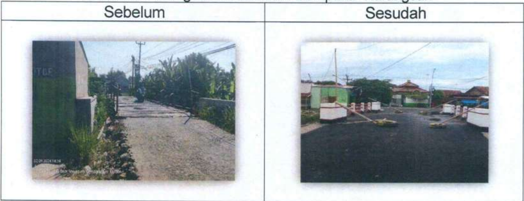
Foto III.5 Rehabilitasi Jembatan Gantung Pada Ruas Jalan Cihowe -Tonjong Sebelum Sesudah
