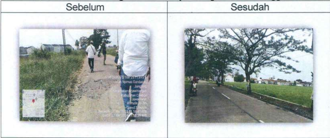
Foto III.3 Pemeliharaan Berkala Jalan Sindanglaut -Ciawigajah Sebelum Sesudah
